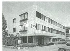
福北工場事務所棟外観
