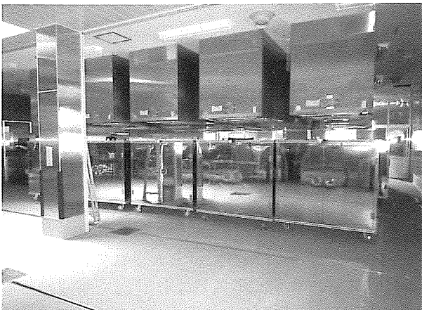
同社の施工例（学校給食センター消毒室）。
