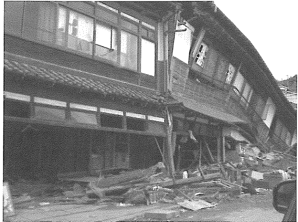
崩壊した屋敷。
