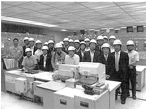
武豊火力発電所制御室
