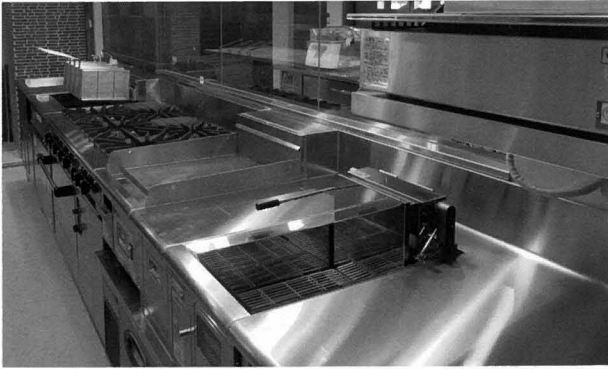
参考写真1-2 参考写真1-1の現場写真を別の角度から撮影したもの。隣合わせに配置した機器の奥行き寸法の違いやバックガードの形状の違いがあり、SUS塞ぎカバーを採用して収めている。甲板の手前かまちはフルRに統一している。このために、一部の機器は甲板部分を改造している。
