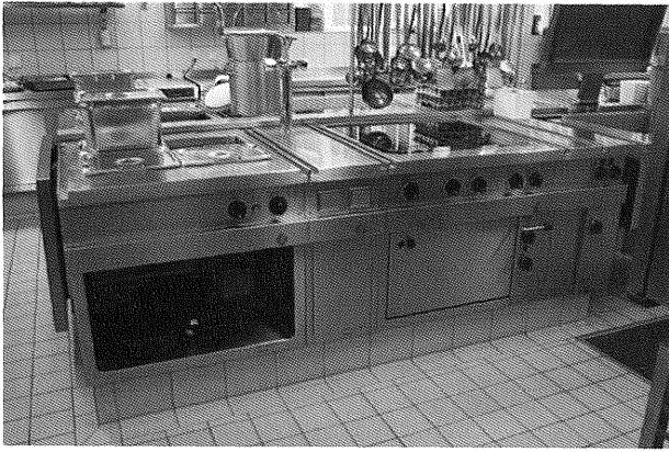
写真12 ベース置き工法の事例／ドイツ
