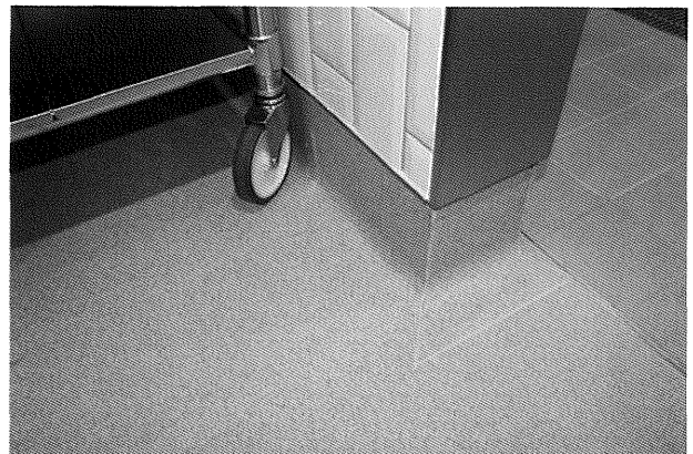
写真2 床仕上げ事例（シート仕上げ）／日本
