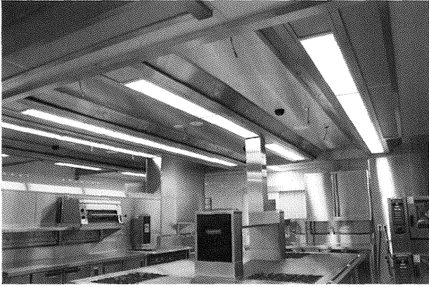
写真8 天井仕上げ事例（天井換気システム）／日本
