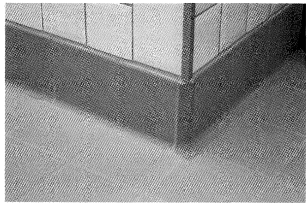
写真1 床仕上げ事例（タイル仕上げ）／日本
