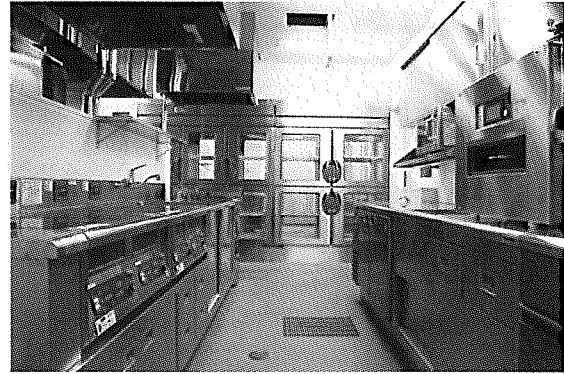
総合病院の、400床対応ニュークックチルシステム採用の総合病院給食厨房設備
