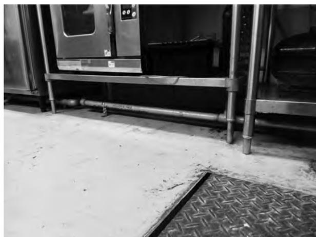
写真2 作業台の下を通るガス配管
